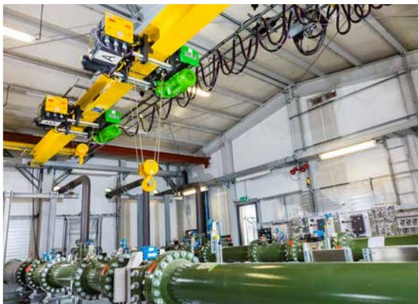
1 A ponte rolante em tandem com proteção antideflagrante com dois diferenciais de cabo SH e controlo remoto por rádio é utilizada na construção de uma estação de compressores para uma tubagem de gás natural. Os diferenciais de cabo SH 40 Ex foram concebidos para capacidades de carga de 3.200 kg cada e em termos de construção e segurança cumprem as diretivas europeias ATEX.
